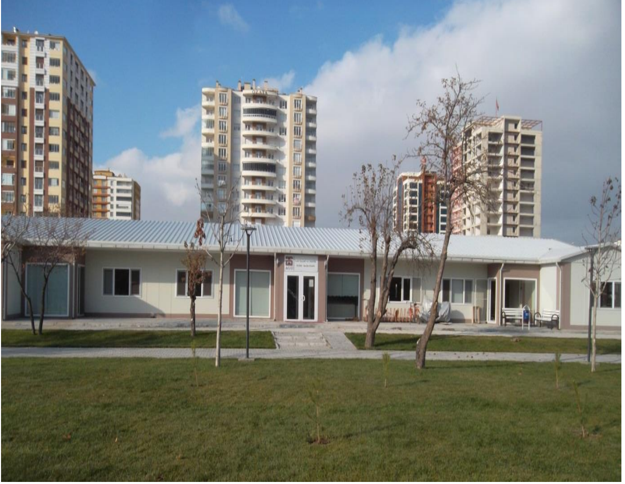
Yapı İşleri ve Teknik Daire Başkanlığı Hizmet Binası
